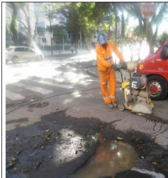
*Foto 1- Requadramento do buraco, primeiramente utilizando a serra diamantada e posteriormente, o martelete*
