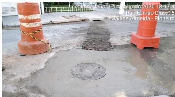
Os anexos acima mostram a construção da boca de lobo, assentamento da guia-chapéu, extensão da sarjeta, construção de ramal e construção do poço de visitas.
