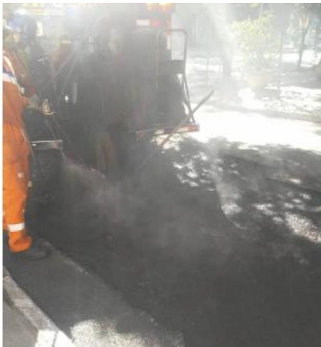
*Foto 3 – Execução de pintura com emulsão asfáltica*
